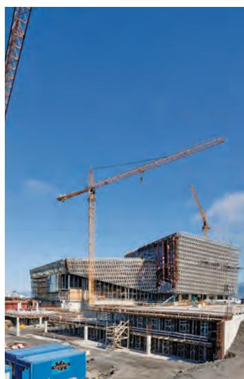
Í bílastæðahúsið fóru 25.000 rúmmetrar af steypu, 3000 tonn af steypustyrktarstáli, 18.500 fermetrar af kúluplötu og 491 bergankeri. Dýpst punktur bílageymslunnar liggr 12 metrum undir hæstu áætluðu sjávarstöðu.
