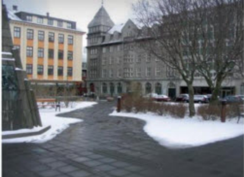
Snjóbræðsla á Austurvelli í miðbæ Reykjavíkur
