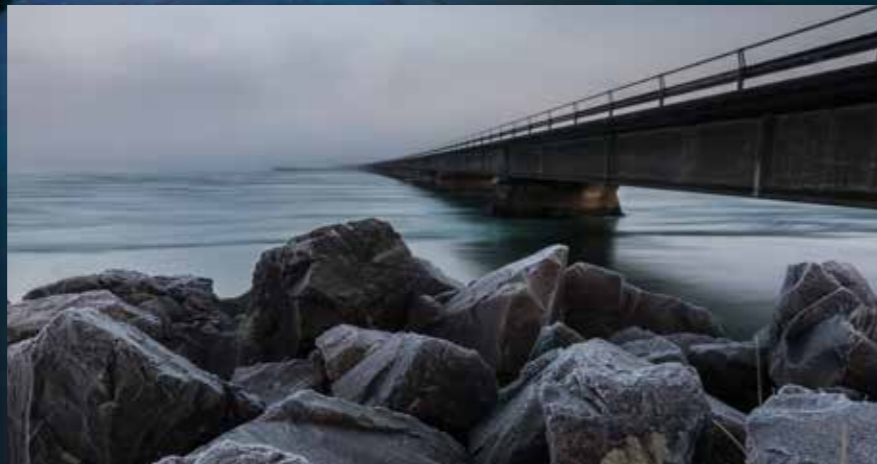
连接Borgarnes和1号国道的Borgarfjarðarbrú桥
