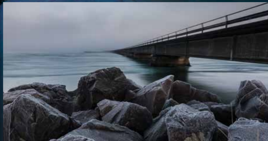
连接Borgarnes和1号国道的Borgarfjarðarbrú桥
