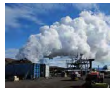
Hola IDDP1 í blæstri – takið eftir að sjá má í gegnum yfirhitið gufuna næst grjóti og malari augnum sem notaður er til hjóðeyfingar. Tíraunabúnaður er í bláa gámmum. MYND: KRISTJAN ENNARSSON
