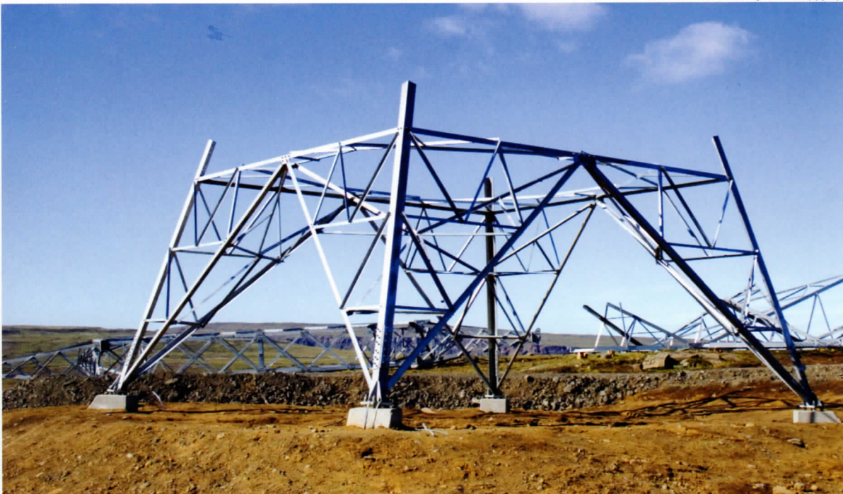
Sultartangalína 3 í byggingu
