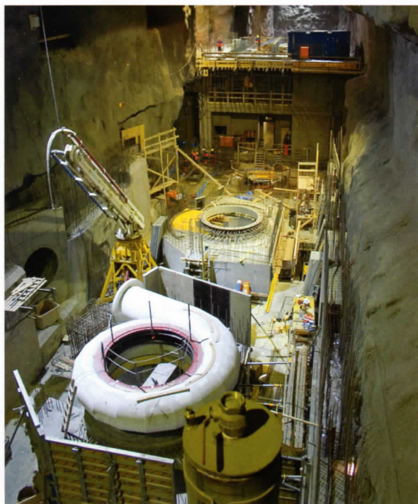
Stöðvarhús í byggingu
